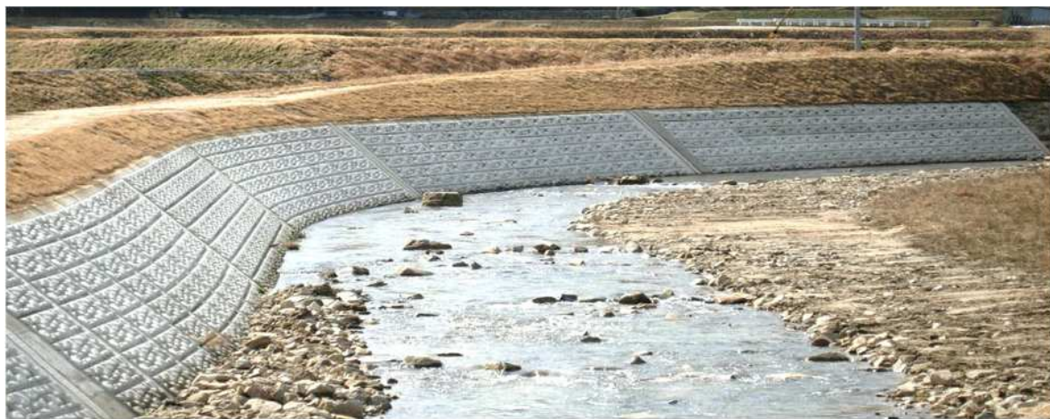
災害復旧(北広島町)
