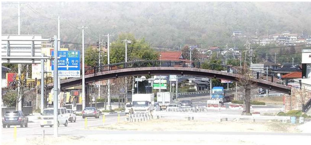
375号バイパス吉土実歩道橋(東広島市)
