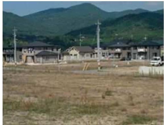
福富ダム代替地(東広島市)
