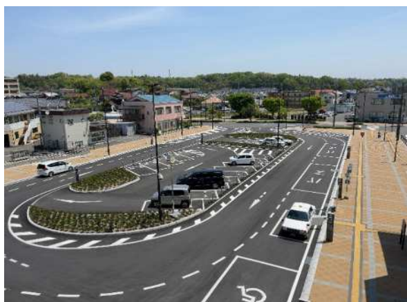
西高屋駅南北駅前広場(東広島市)
