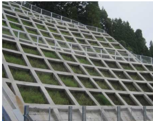
急傾斜地対策(廿日市市)
