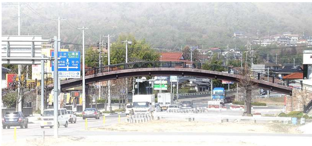
375号バイパス吉土実歩道橋(東広島市)
