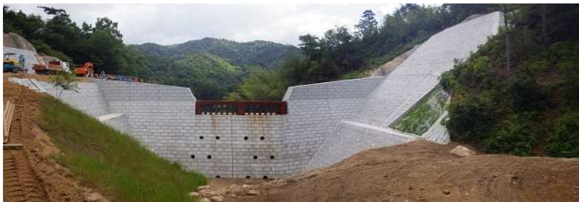
砂防堰堤(庄原市)
