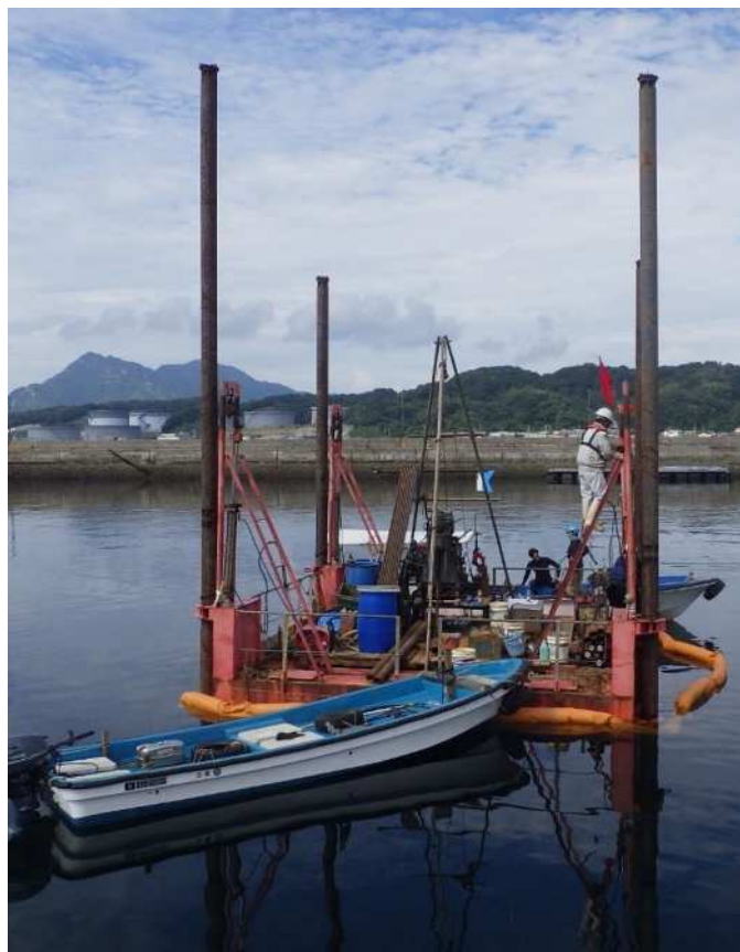
スパット台船を使用した海上ボーリング
